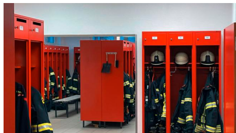
Bild 2: Durch die eingesetzte Funk-Hybrid-Lösung werden auch die verdrahteten Rauchmelder der Umkleide Räume in das Alarmsystem eingebunden (Bild: Indexa)
